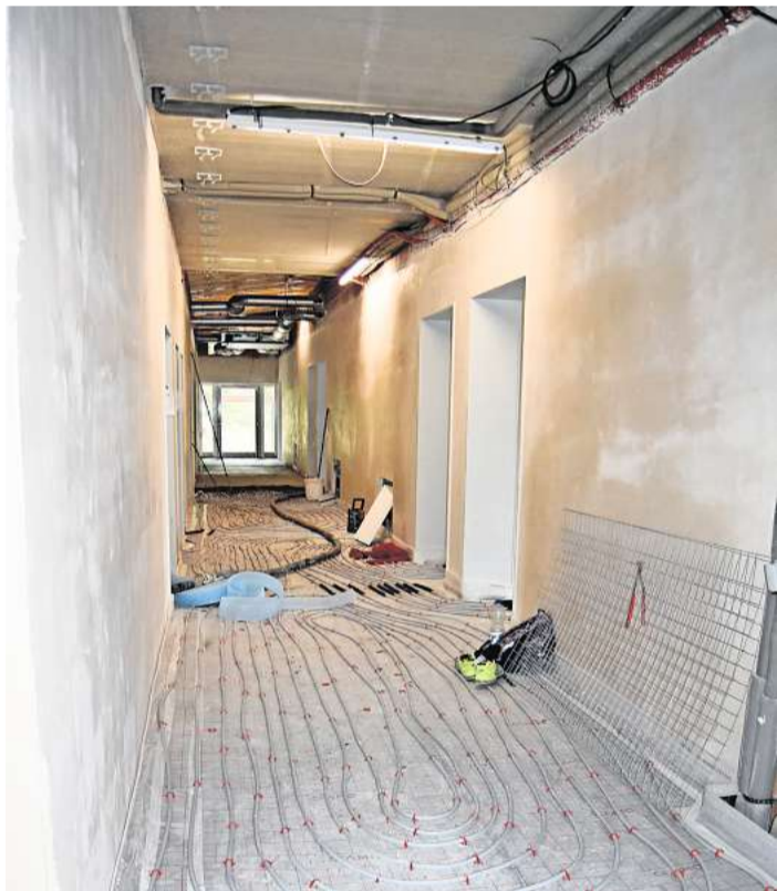
Ein Blick in den Flur: Hier wird noch die Fußbodenheizung installiert.
